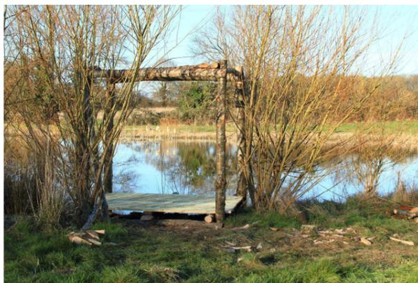
Les traverses sont également en châtaigniers elles sont boulonnées entre elle par des tiges filetées. Les montants sont en bambous et les murs sont tressés avec du genêt.
